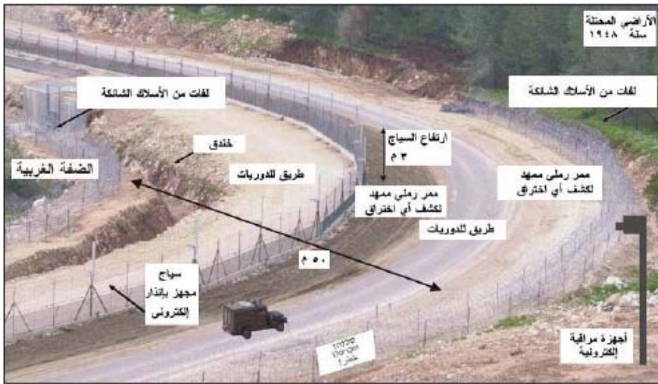
شكل (1) مقطع عرضي يبين مكونات الجدار
